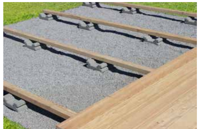
Sichere Fundamentierung: Der Fundamentstein schützt die aufgelegte Unterkonstruktion vor dauerhafter Feuchtigkeit.
